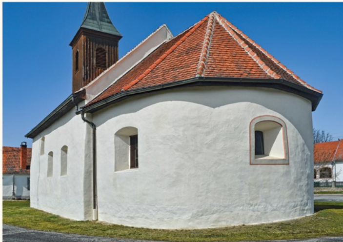
Die katholische Filialkirche Siget in der Wart (Ansicht von Südosten). Der Festtag des Apostels Paulus, dem das Gotteshaus ursprünglich geweiht war, ist der 29. Juni. Bemerkenswert ist, dass durch den im 13. Jahrhundert erfolgten Wechsel zum heiligen Ladislaus das Patroziniumsfest nur um einen einzigen Tag, auf den 30. Juni, verlegt werden musste.
